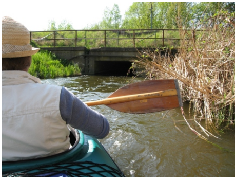
Flacher Tunnel unter der Eisenbahn.
