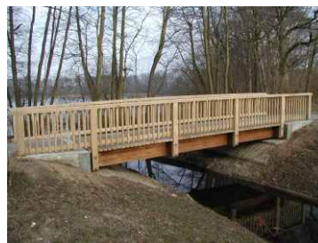
Die Brücke für den Radfahweg über die Verbindung von Dieksee zum Suhler See ist fertig und befahrbar.
